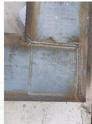
止水钢板焊接样板
