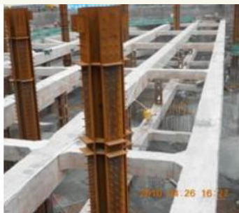
钢筋混凝土支撑无声 爆破拆除技术
