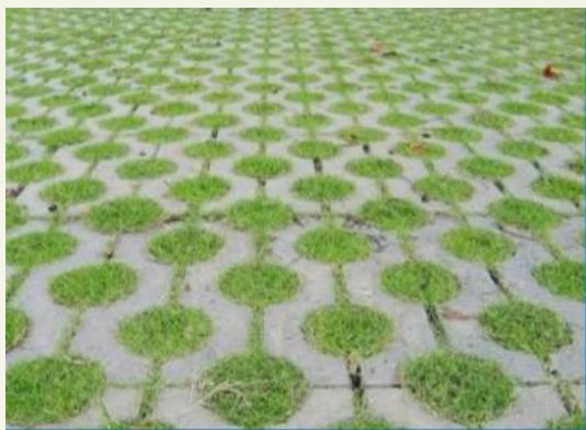
停车位铺设植草砖
